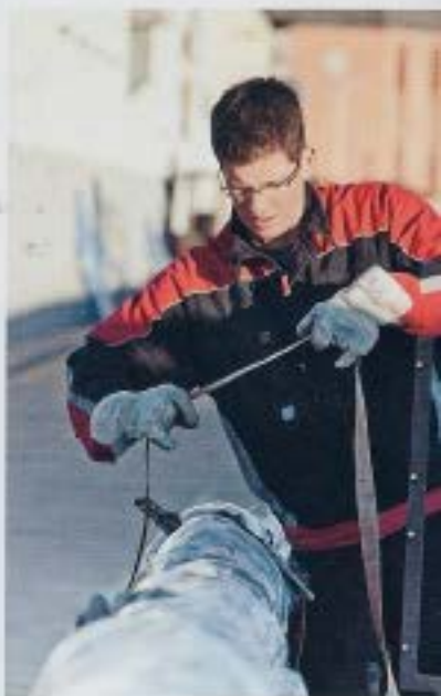
Konzentration: Als Erstes sichert Thomas den Mast
